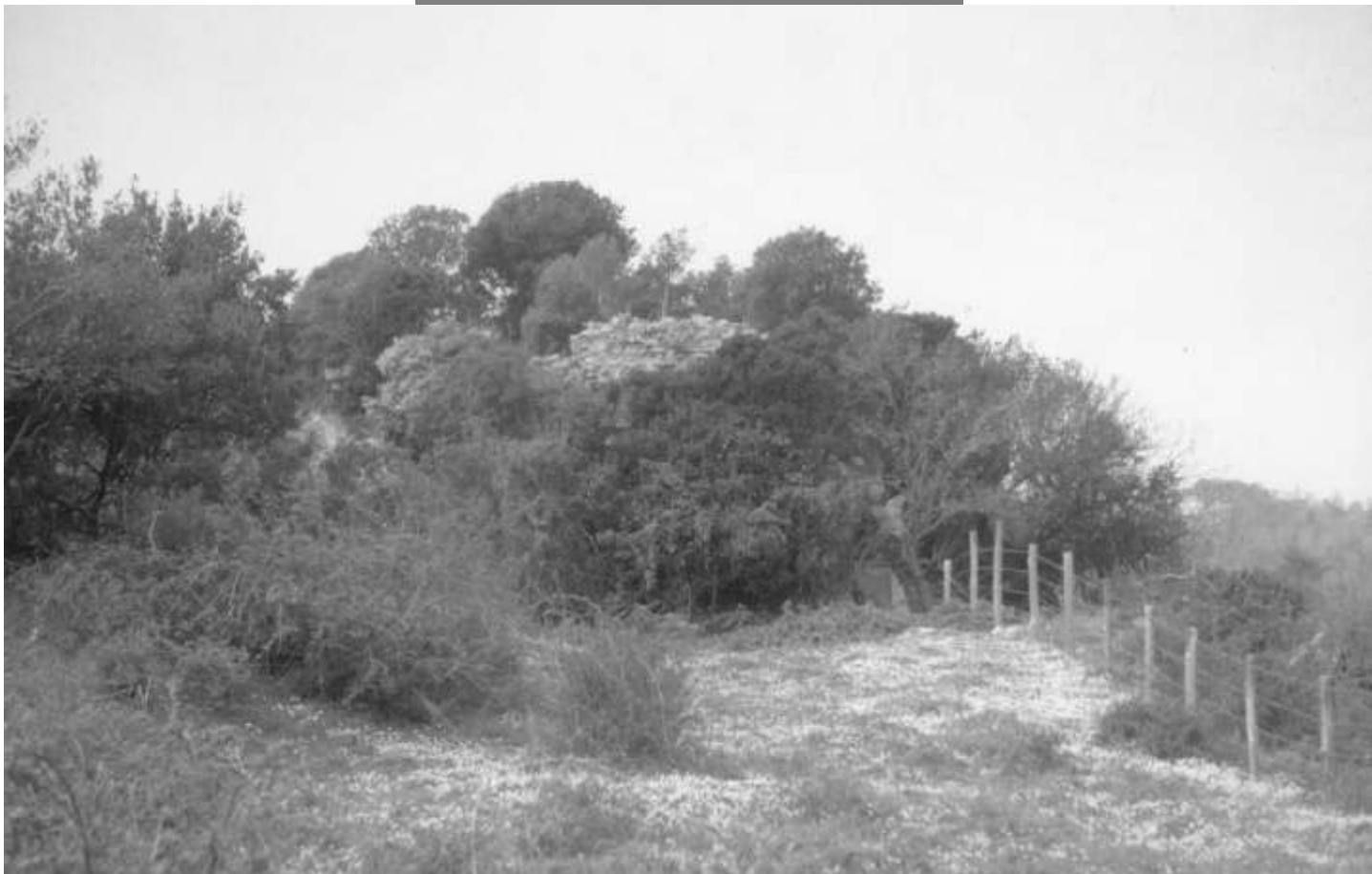
Strutture murarie superstiti sullo sperone roccioso
